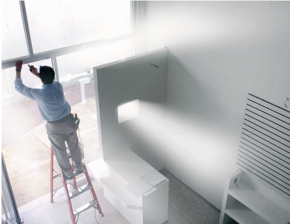
Instalaciones y levantamiento de estructuras
